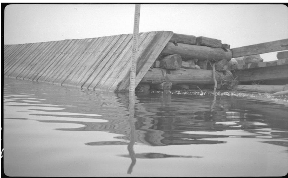
Figure 1. A manual gauge on the Ottawa River, at La Passe, ON. Credit: Y. Déguise, 1942. E6, S7, SS1, P7008, Bibliothèque et Archives nationales du Québec.
